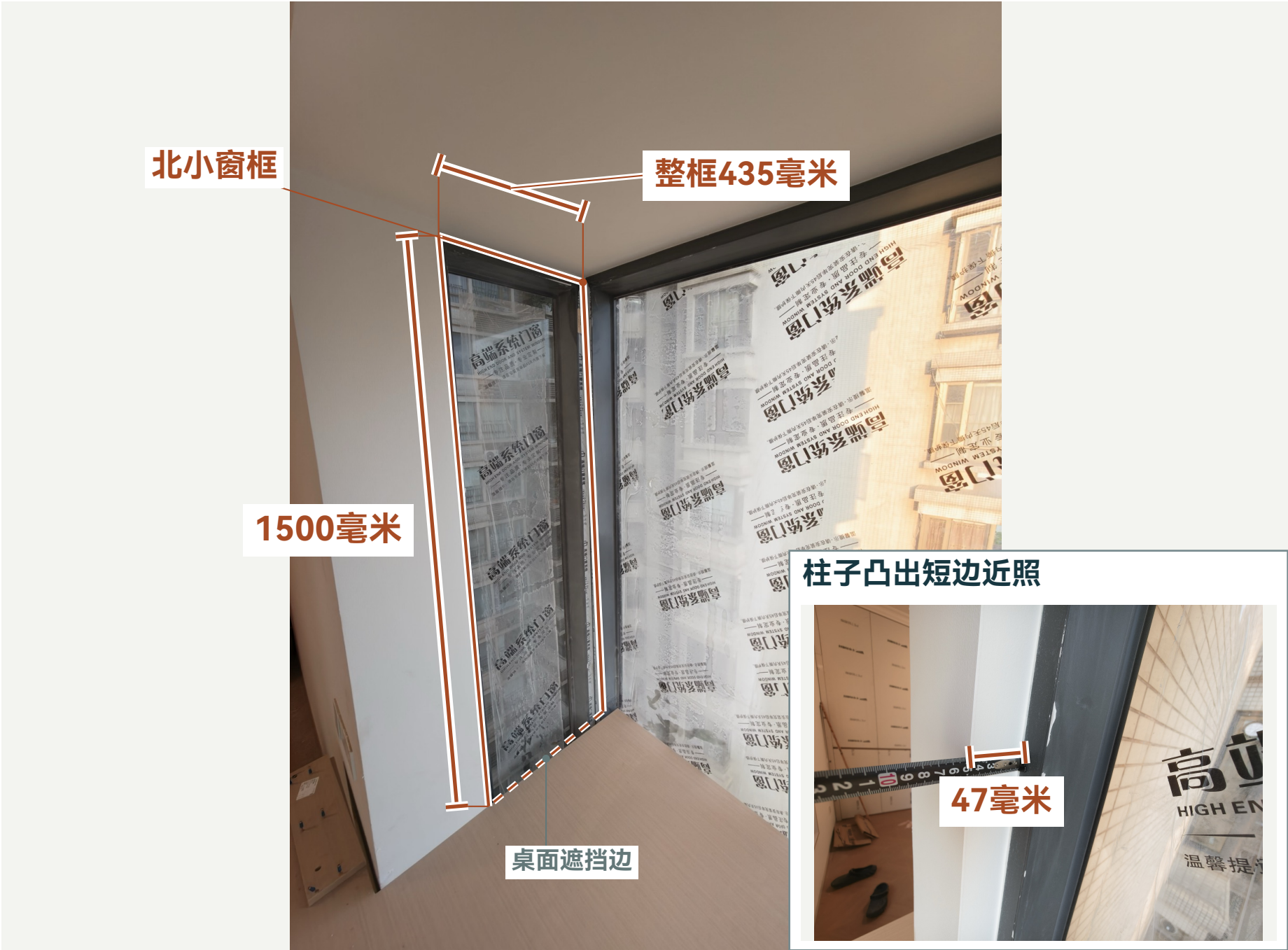
新实测：北小窗整框435毫米
