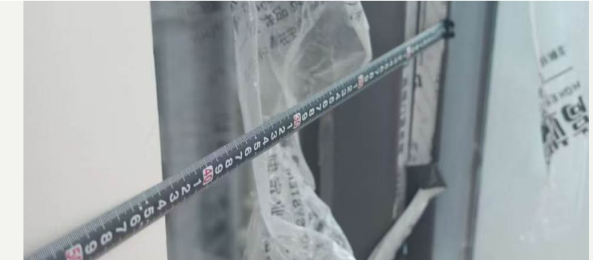
新实测：北小窗整框435毫米
